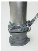
⑤ グリップ用ボルト、及びナットをワッシャと共に装着し、標準トルクで締め付けます。
