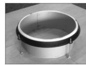
6. 受枠周囲の溝にコンクリートが入らないよう養生材を押し込み取り付けます。
