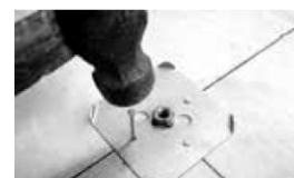
本体の下部に高さ調節用のスペーサーを差し込み、固定ボルトのほぼ中心に設置してください。
