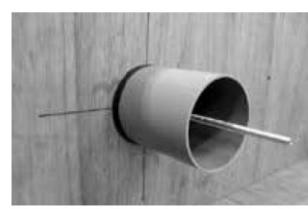
ドレン本体をスペーサーに合わせてセットし、LK3 固定金具と蝶ナットで締付け固定します。ドレン本体が水平であることをご確認ください。
